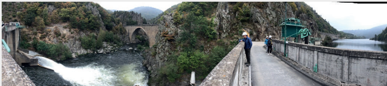
Photo 4. Réservoir de Poutes sur l'Allier (France).
