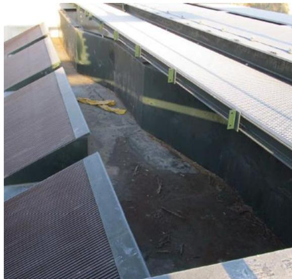
**Figure 26.** Goulotte au sommet d'un plan de grille incliné. L'écoulement va du haut vers le bas sur la photo et la goulotte s'élargit au fur et à mesure que les exutoires de dévalaison y débouchent (photo D. Courret - OFB).
