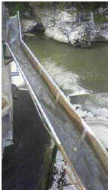
**Figure 27.** Système de transfert des poissons dévalants, en aval d'un plan de grille et d'une goulotte collectrice (photo D. Courret - OFB).
